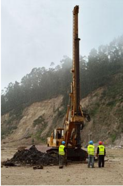
Figura 11: Perforación de pozos para instalación de ductos en el antiguo botadero de Zámbriza.
