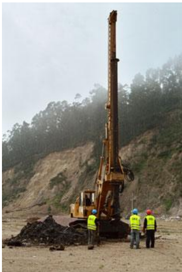
Figura 2: Perforación de pozos para instalación de ductos en el antiguo botadero de Zámbriza.
