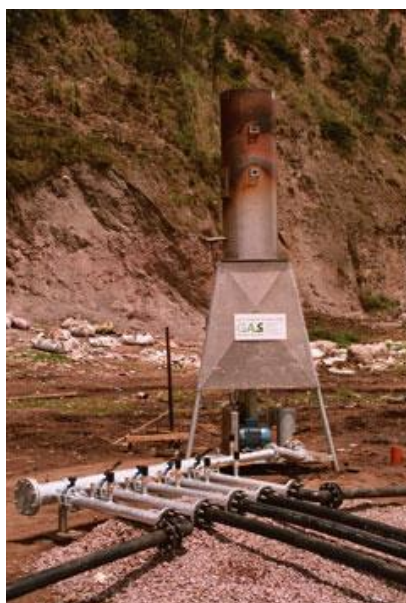
Figura 4: Antorcha o “flare” usada para quemar el gas recuperado en el antiguo botadero de Zámbriza.
