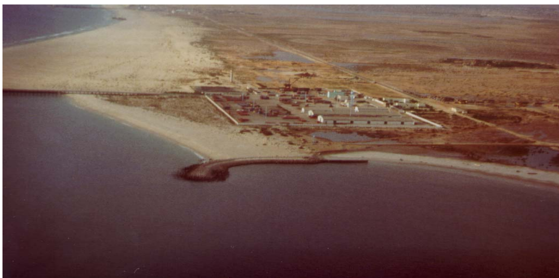
Photo 2 : Vue partielle des installations portuaires en septembre 1998 (ensablement au Nord de la digue portuaire et érosion au Sud de l'épi)
