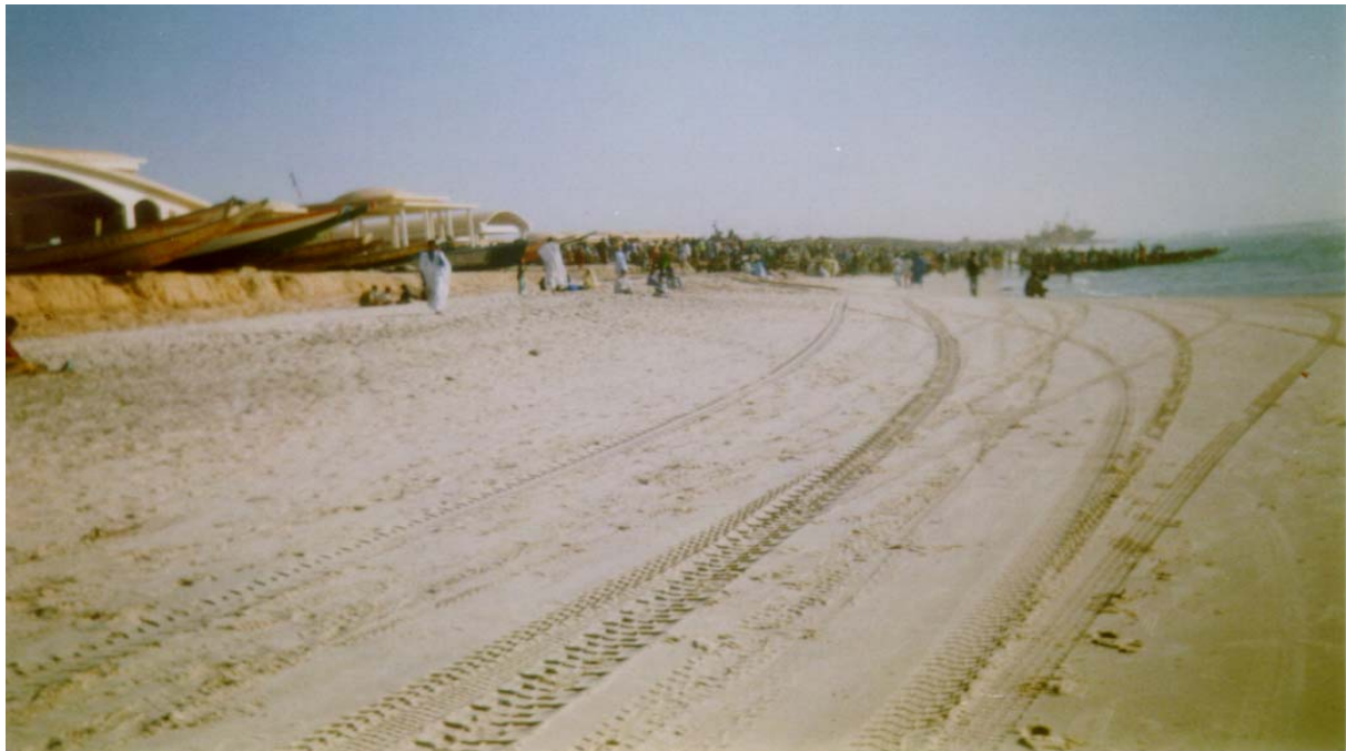
Photo 1 : Erosion au droit du marché aux poissons suite à la tempête du 14 décembre 1997(photo : A.O. ELMOUSTAPHA)
