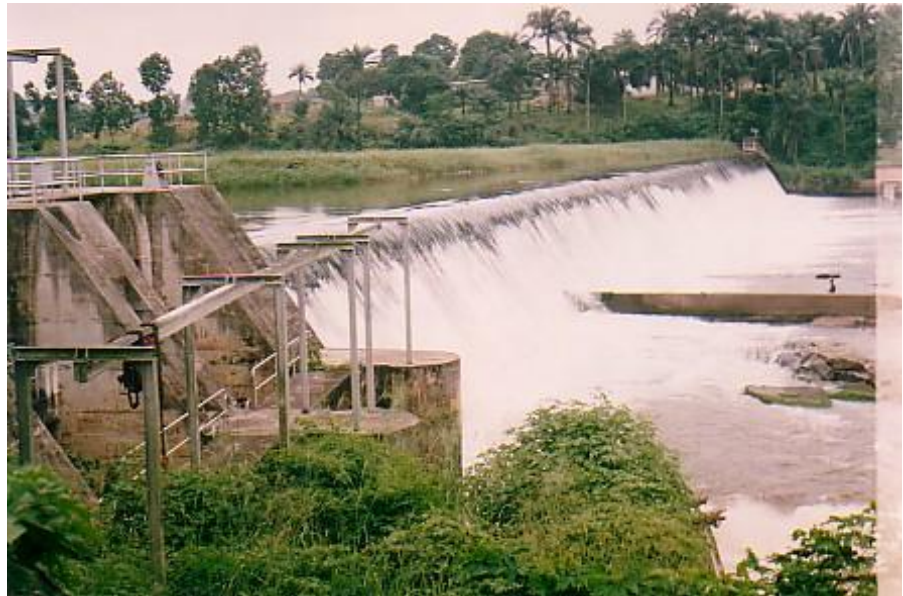
Figure 3 : Barrage hydro-électrique du Djoué (Brazzaville-Congo)
