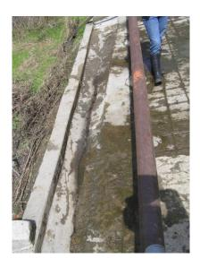
Figura 58: Canal de recolección de la mezcla de desechos sólidos y agua
