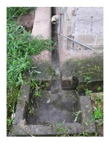
Figura 75: Canal y caja recolectora de desecho porcino
