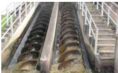
**Figure 27.d. 3 vis d'Archimède**
