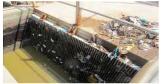
**Figure 27.2 dégrillages moyens – 30 mm**
