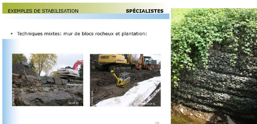
Figure 17 : Exemple de stabilisation des rives de la rivière
