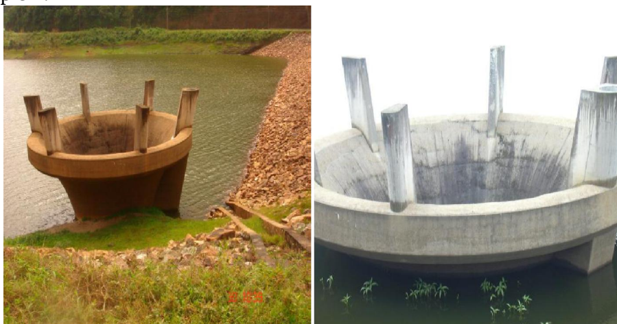
Figure 4&5 : Diminution du niveau d'eau du lac de retenue de Rwegura)
