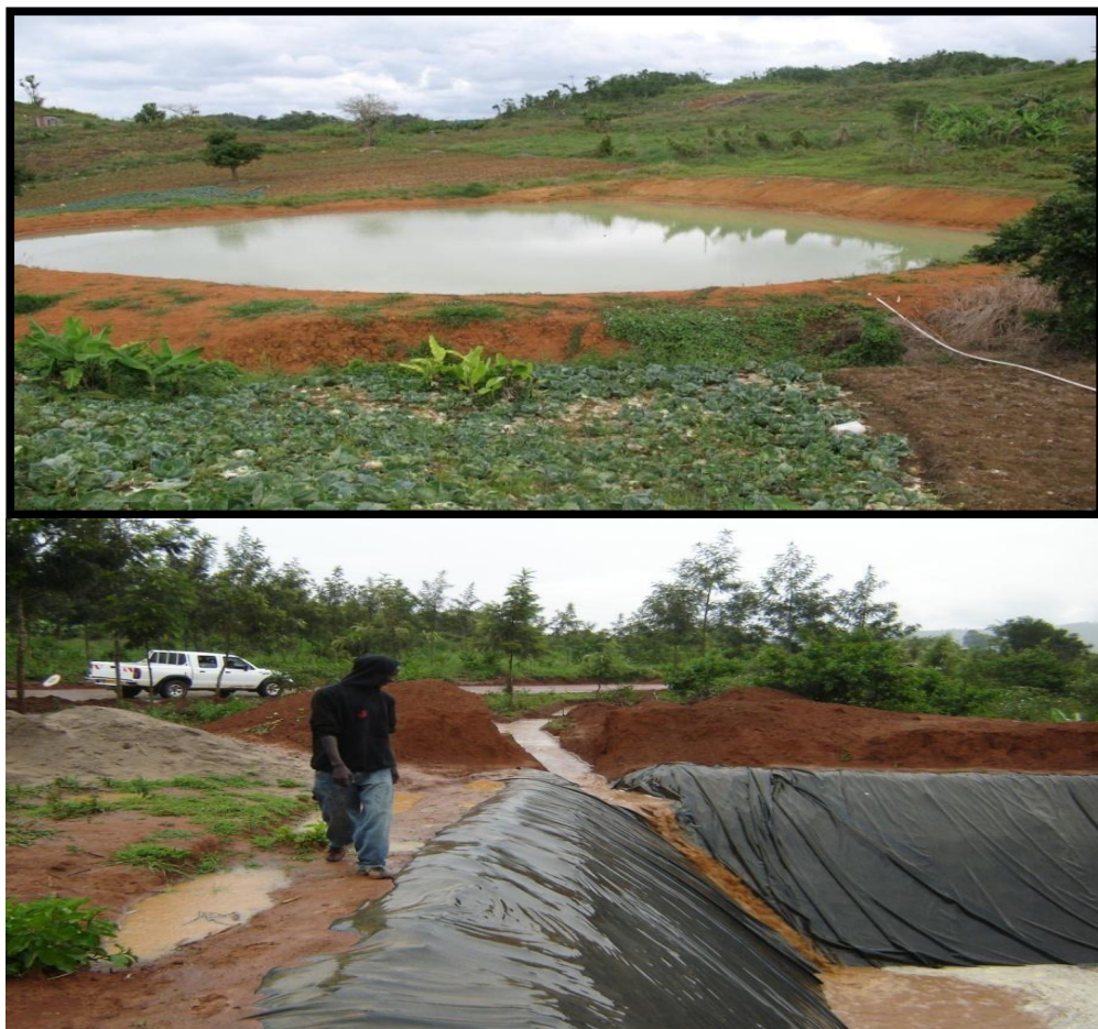
Figure 30 : Exemple de création des lacs de retenues d'eau
