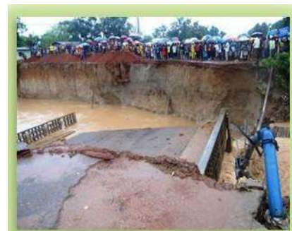
Figure 5.4 : Pont écroulé après érosion du canal - Source : GONIWA ILONGA Samuel _Aout 2013
