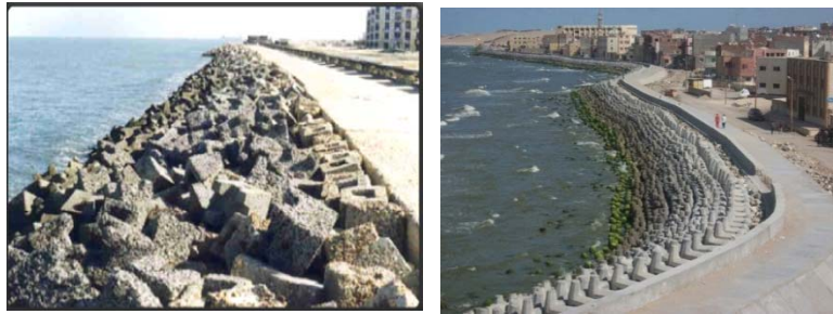
أعمال الحماية الهندسية لصد الأمواج وعمليات النحر في الشواطئ
