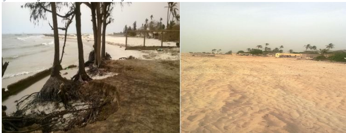
Image 3: Rechargement en sédiments de la plage de Pilote Bar
