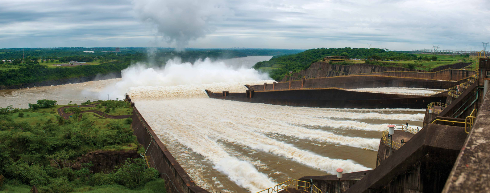
Vertedero de la represa hidroeléctrica de ITaipu, Departamento de Alto Paraná.
