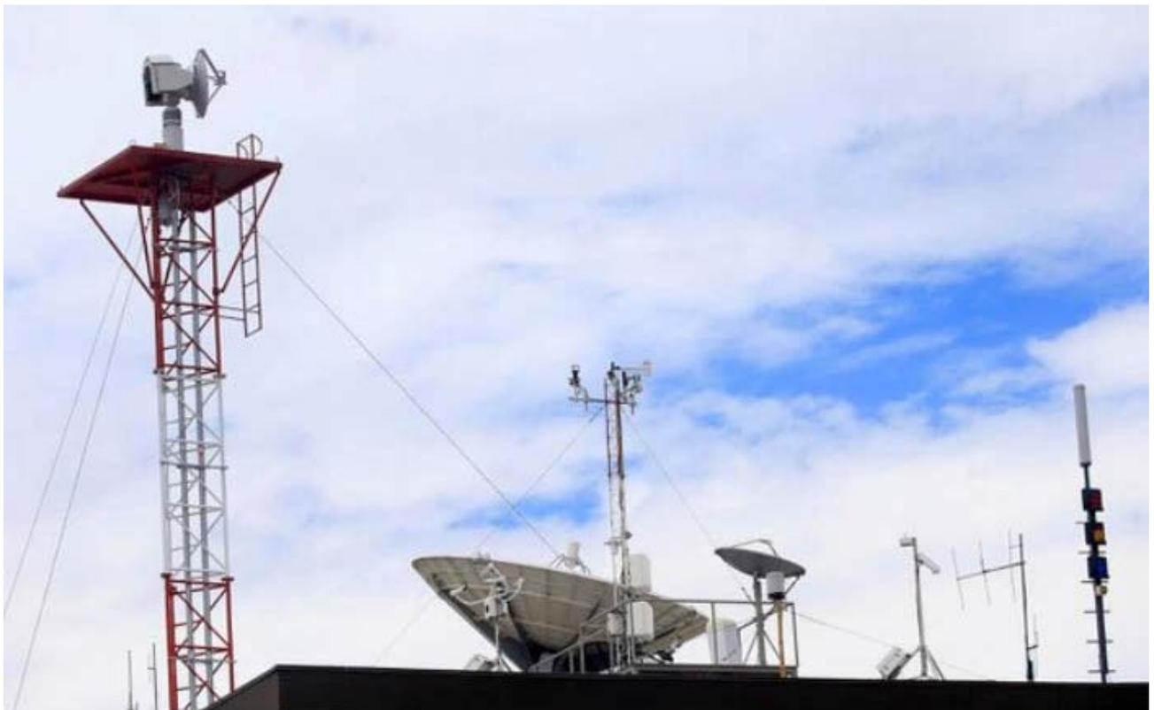
**Figura 5.4** Sistema de recepción satelital del IMN.
