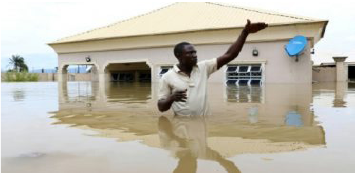
Photo 4.3 : Habitation inondée à Malanville (Nord du Bénin)
