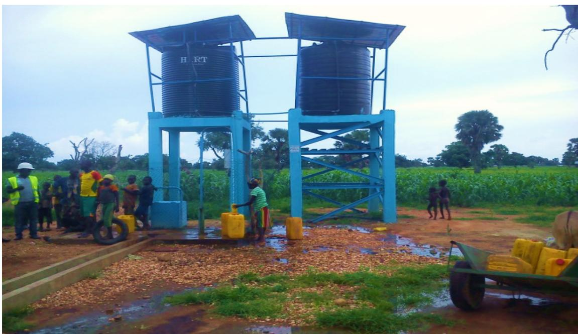
Photo 1.2 : Type d'ouvrage de pompage solaire d'eau dans les localités rurales isolées
