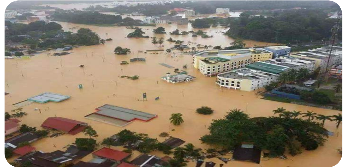
Flooding in Abidjan, Cote D'Ivoire (June 2018)
