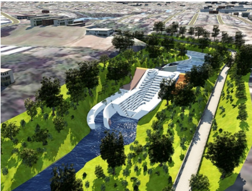
Figura 66. Laguna de laminación en construcción en el arenal de Monserrat del AMSS
