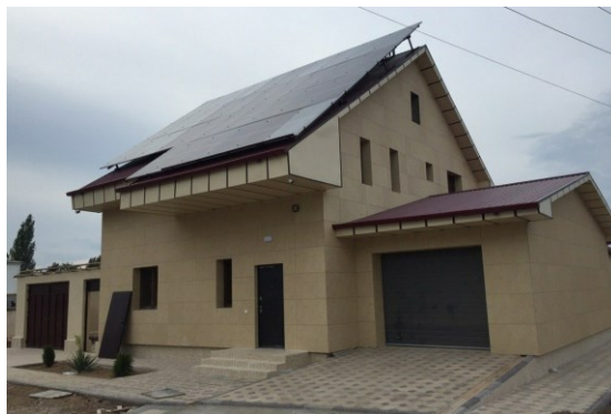
Рис. 3.13 Энергоэффективный дом в Нурафшане
