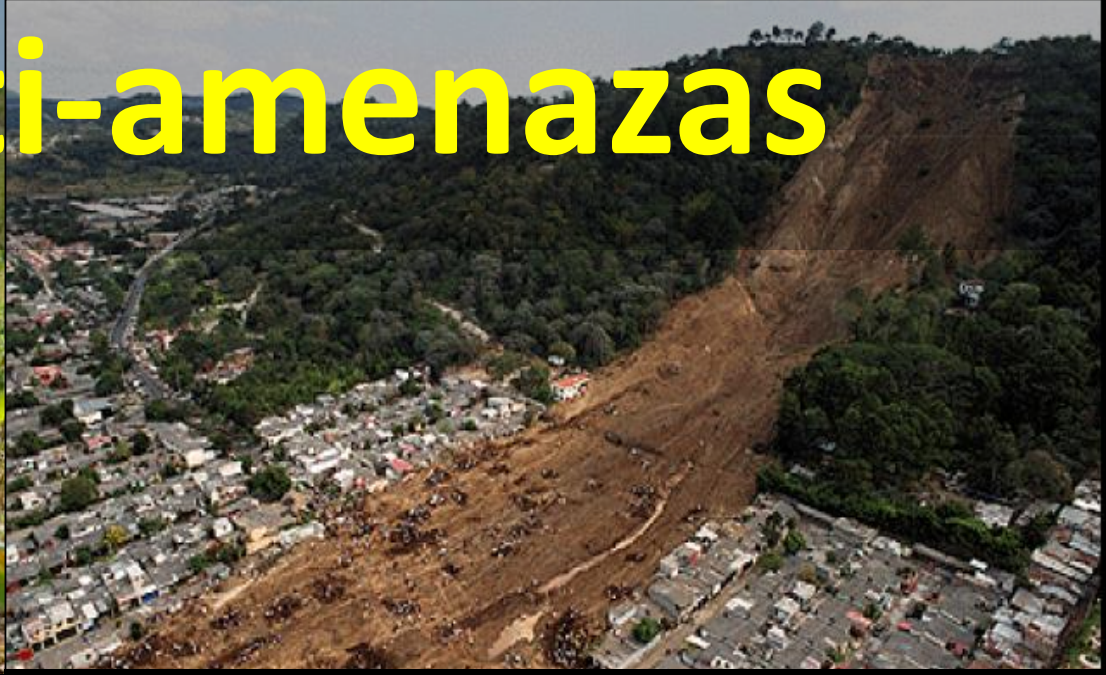
Deslizamientos por sismos
