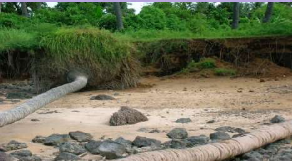
Erosion côtière à Ndroudé
