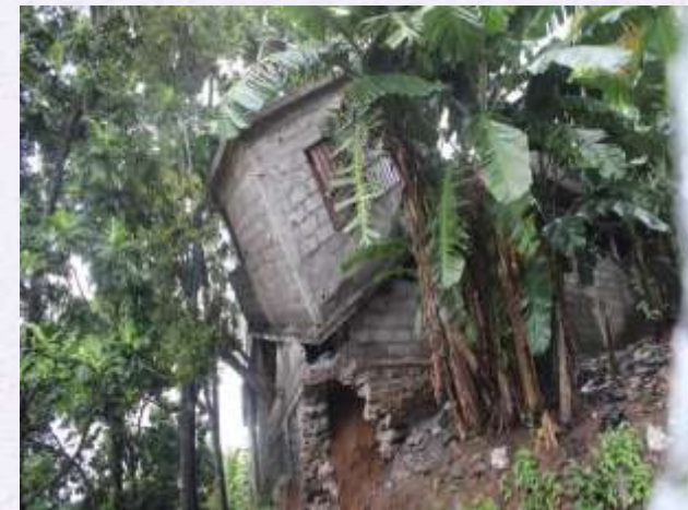
Effondrement de maison
