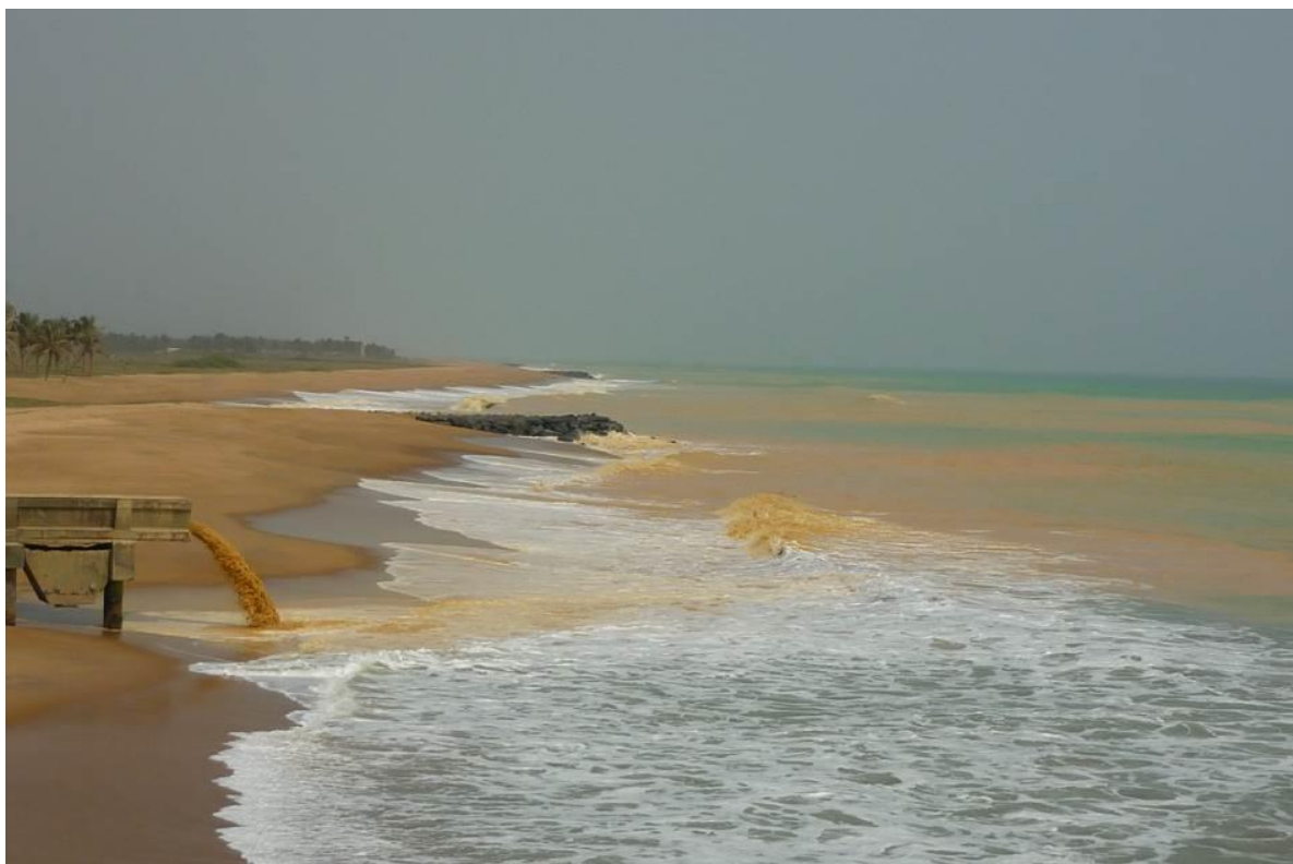
Figure 3 : Déchargement des eaux chargées de boues de phosphates en mer
