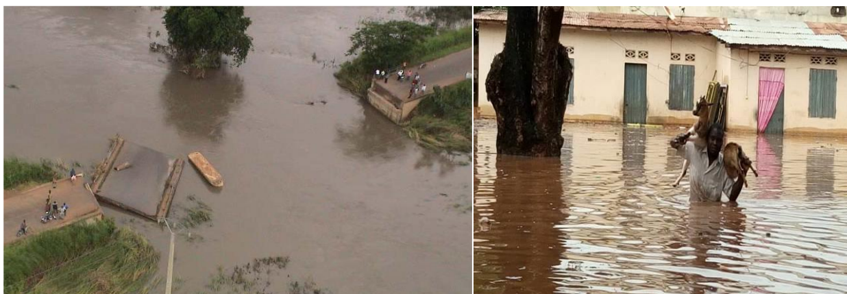
a. Rupture du pont d'Amakpapé suite aux inondations en 2008
