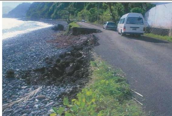
Figure 17 : Route endommagée par la remontée du niveau de la mer (Route de Pouzini – Anjouan)
