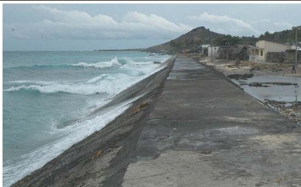
Figure 16 : Débordement de la digue de protection du village de Bangoi-Kouni (Nord de Gde-Comore) par les houles et inondation de deux quartiers (1<sup>er</sup> mars 2006).
