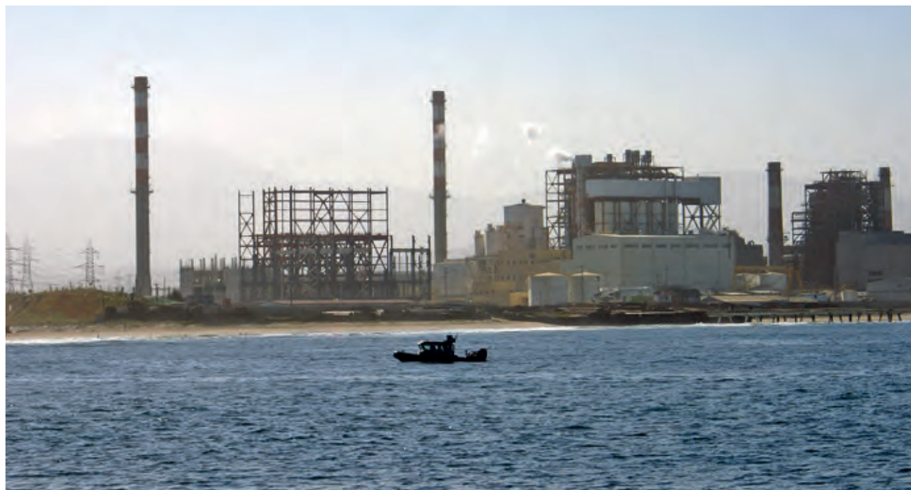
Central termoeléctrica, Archivo MMA.
