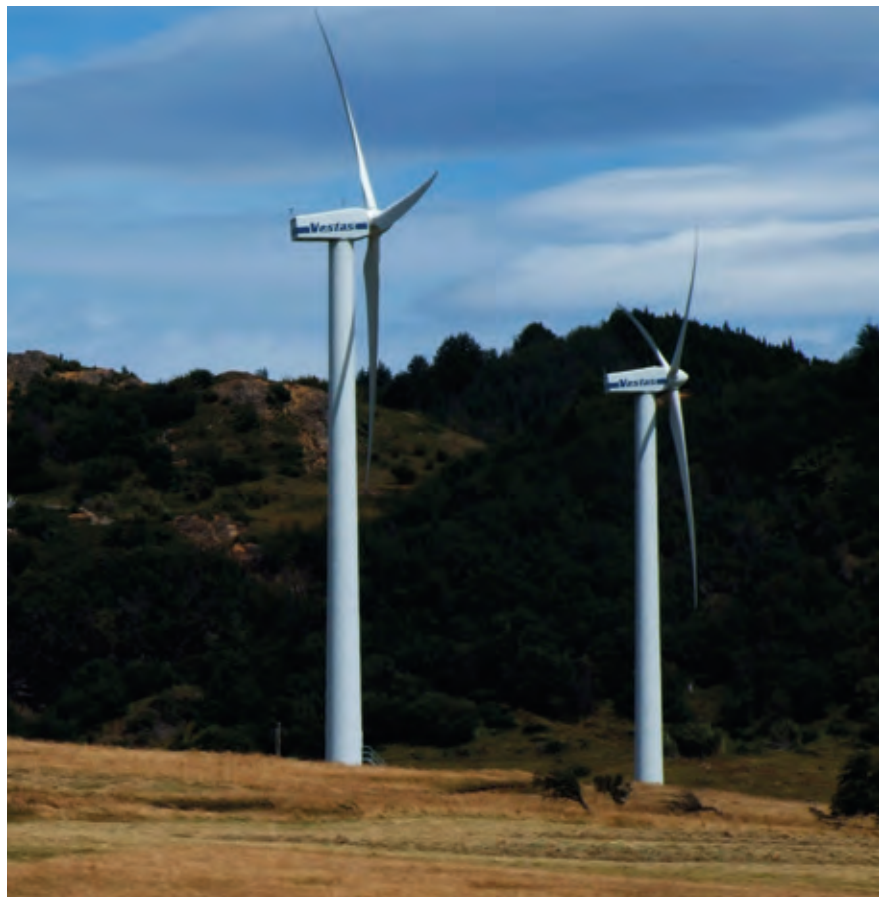
Carretera Austral, Parque Eólico.
