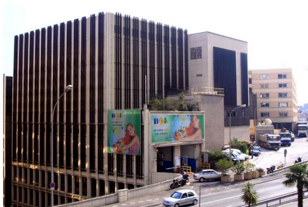
L'Usine d'Incinération des Résidus Urbains et Industriels (UIRUI), unité de traitement et de valorisation des ordures, est équipée de trois fours chaudières dont deux peuvent fonctionner simultanément. En 2005, la Principauté a engagé les travaux de mise aux normes du traitement des fumées de l'UIRUI, conformément à la nouvelle réglementation européenne (1) sur l'incinération des déchets.
