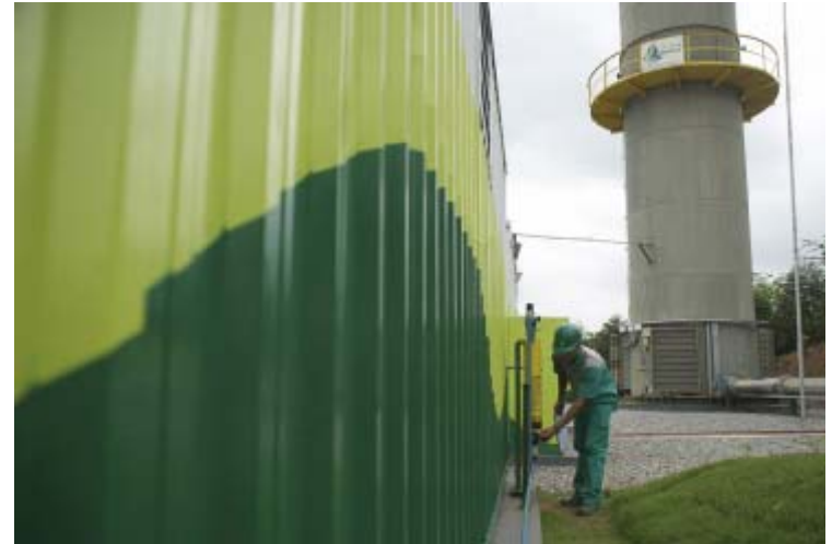
Landfill Gas Collection
