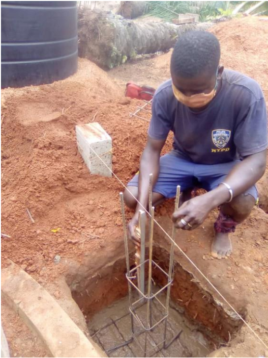
Travaux de fondation (fouille + semelle des pôteaux) pour la construction du château d'eau
