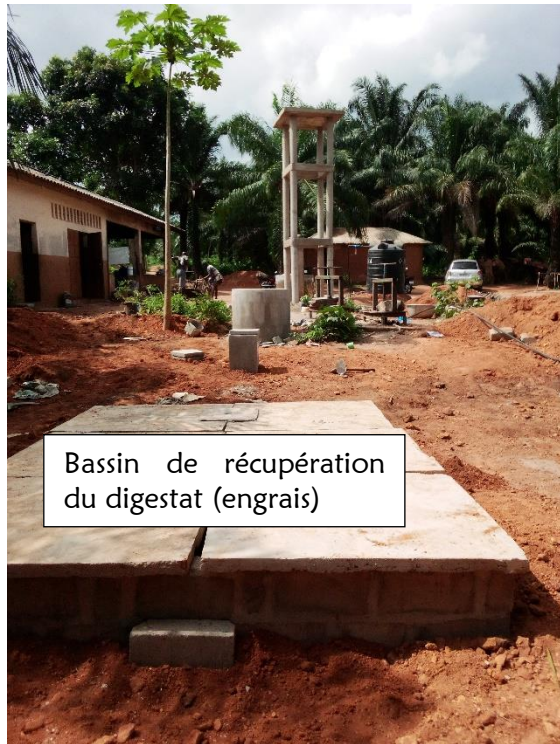
Achèvement de la construction biodigesteur
