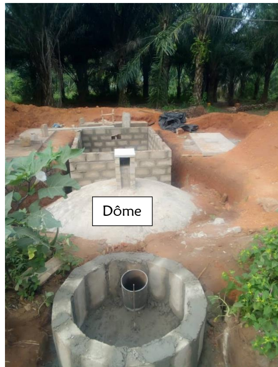
Achèvement de la construction du dôme
