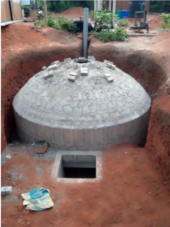
Achèvement de la construction du dôme
