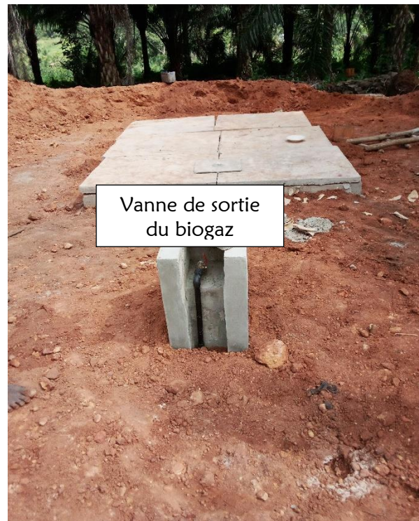
Achèvement de la construction biodigesteur
