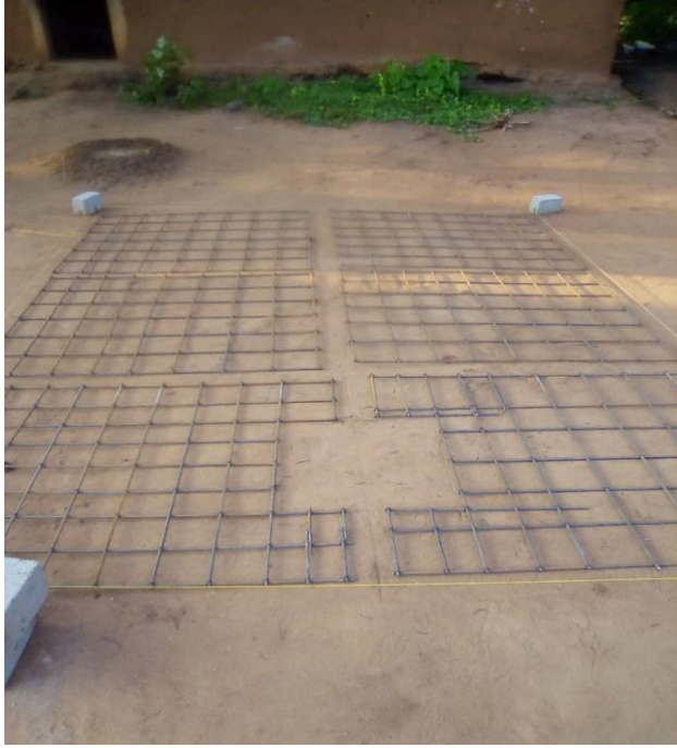
Démarrage des travaux de la construction du dôme du biodigesteur
