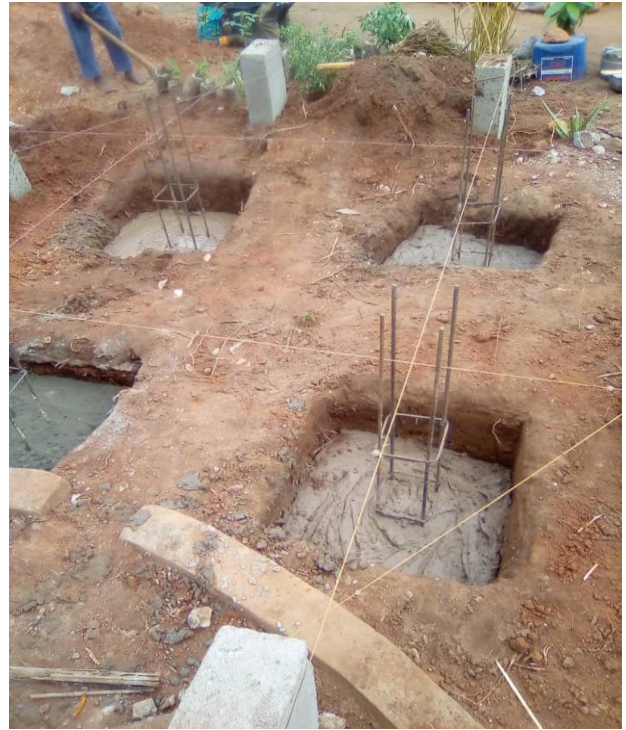
Travaux de fondation (fouille + semelle des pôteaux) pour la construction du château d'eau
