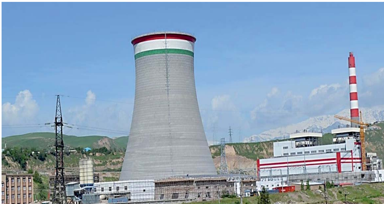
Фото. ТЭЦ в г. Душанбе
