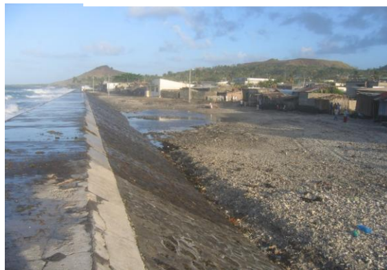
Photo 19 : Digue à Bangoi- Kouni
