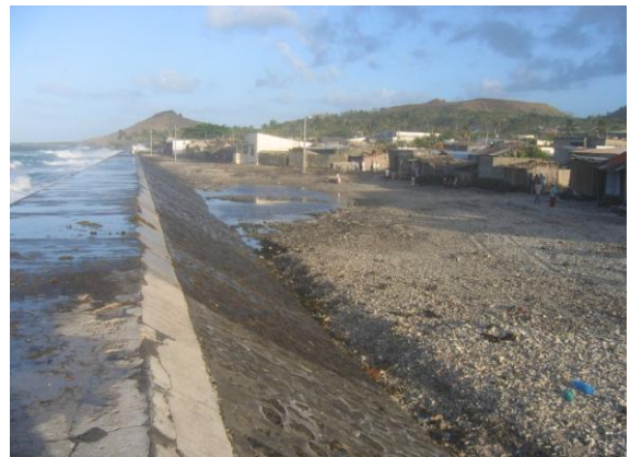
Photo 22 : Digue à Bangoi - Kouni
