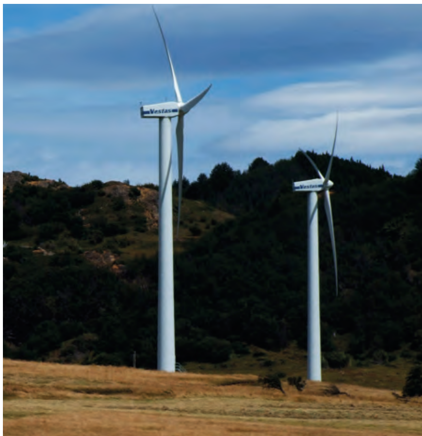
Carretera Austral, Parque Eólico.
