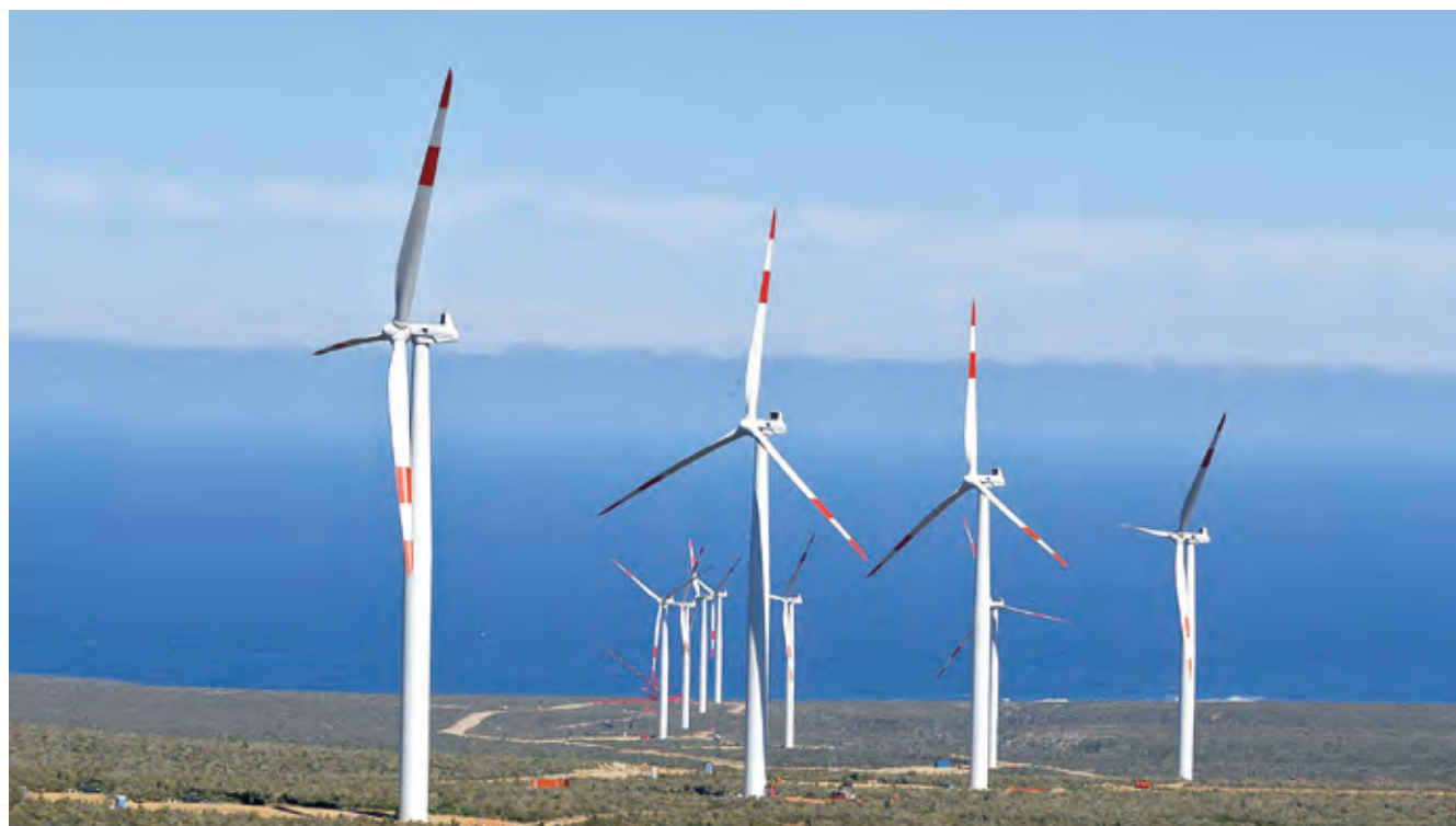
Parque Eólico Carrelá.
