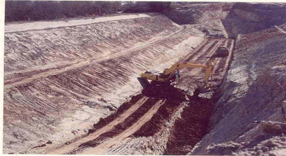
Photo 4.3: Travaux de construction du barrage souterrain - 3
