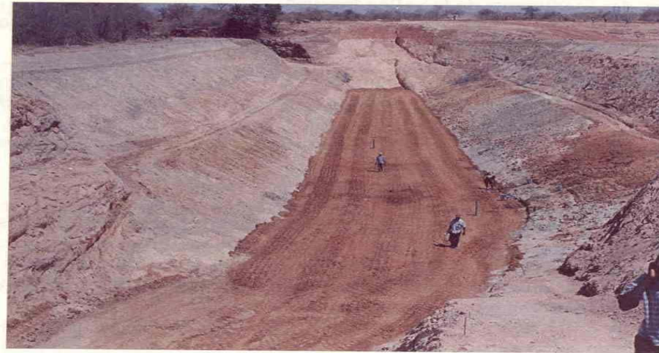
Photo 4.4: Travaux de construction du barrage souterrain - 4
